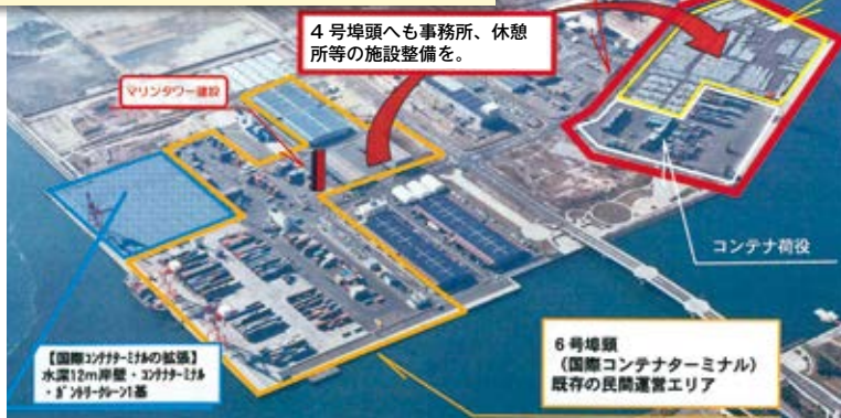
▲マリンタワー建設
